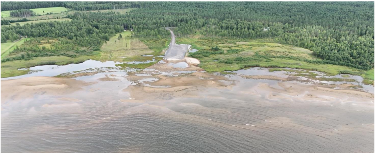
Vaaranlahden uusi tieyhteys ja pysäköintialue.
