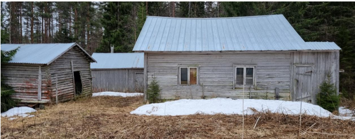
Kuva 37. Pihapiirin etelälaidalla on kolme talousrakennusta. Hirsirakenteinen rakennus, jossa on pihan puolella ikkunat, lienee vanha navetta. Sen päädyssä on erillinen huussi. Navetan vieressä on lato, jonka sisäänkäynti sijaitsee navetan päädyssä olevaa sisäänkäyntiä vastapäätä. Ladon takana näkyy vaja/varastorakennus. Rakennukset ovat vanhassa asussaan, katteet on uusittu.
