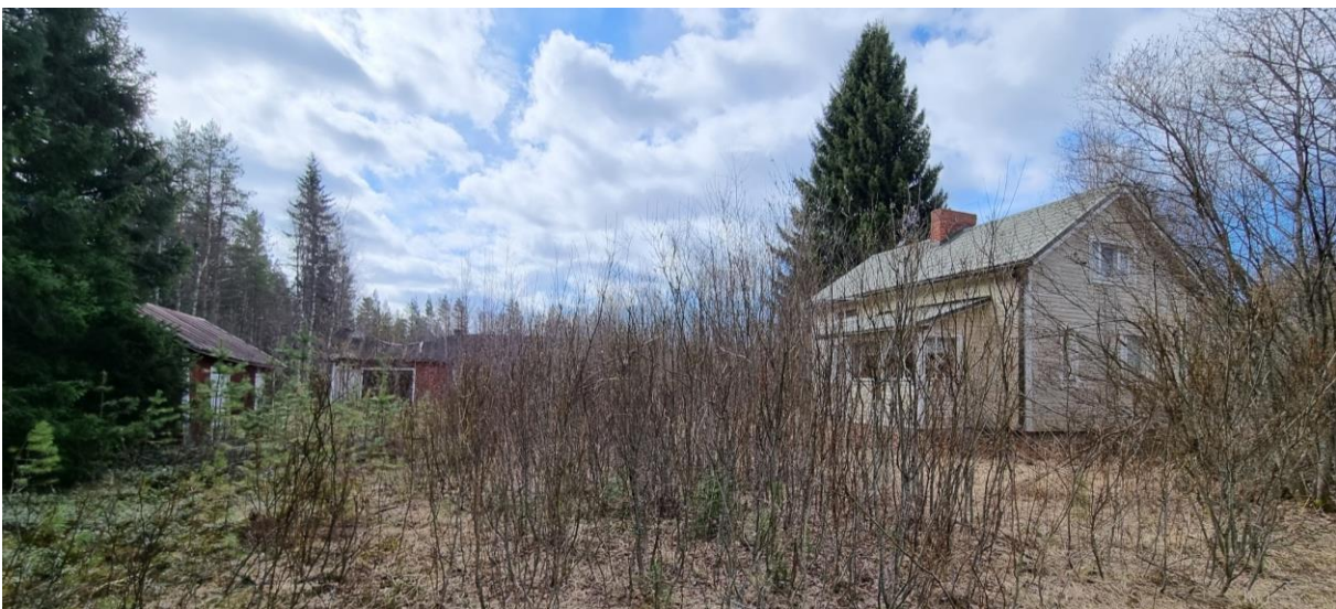
Kuva 42. Näkymä pihapiiriin pohjoisen suunnasta. Asuinrakennus sijaitsee pihan länsilaidalla, sitä vastapäätä on aitta/varastorakennus, taustalla näkyy navetta/varastorakennus.
