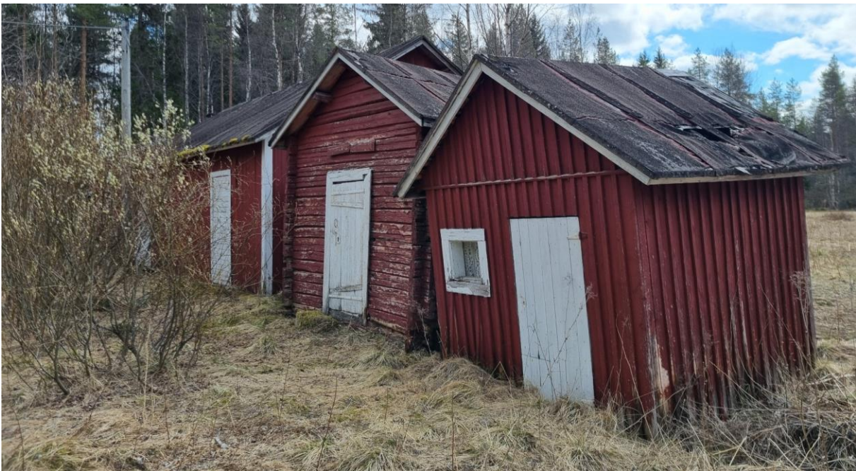
Kuva 46. Pitkän navettarakennuksen päädyssä on kaksi pikkuaittaa.
