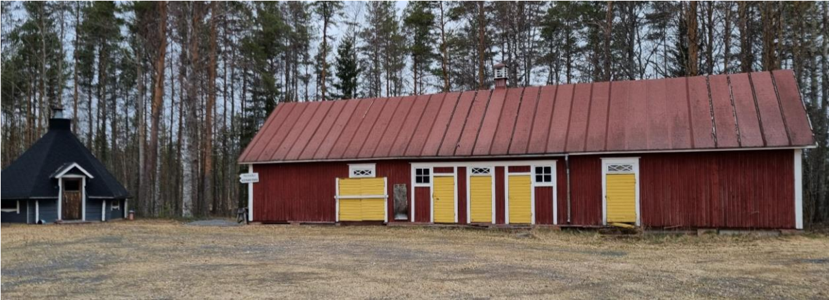
Kuva 54. Ulkokuonerakennus sijaitsee pihapiirin pohjoislaidalla.
