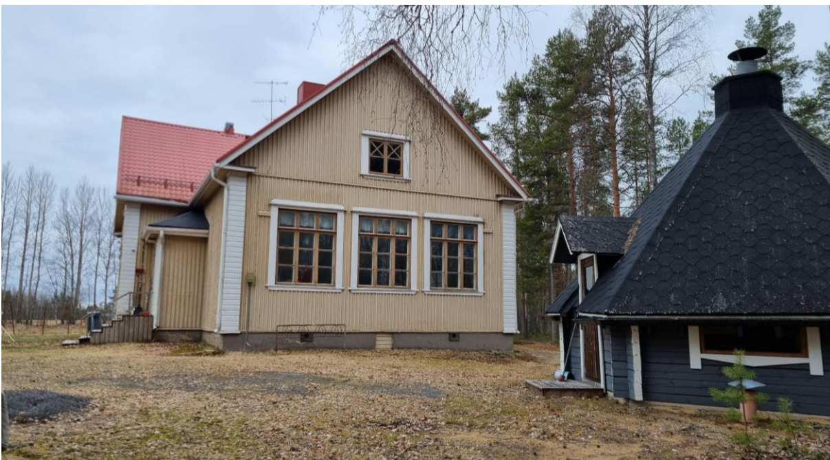
Kuva 53. Koulurakennuksen pääty pohjoisen suuntaan ja grillikota. Koulurakennuksen päädyssä erottuvat luokahuoneen suuret ikkunat.
