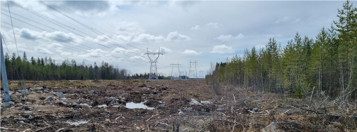
Kuva 29. Voimajohtokäytävä. Kuva sähköaseman koillispuolelta Pöytäpuunnevan tienoilta, missä rinnakkain kulkee paikallisesti kolme voimalinjaa.
