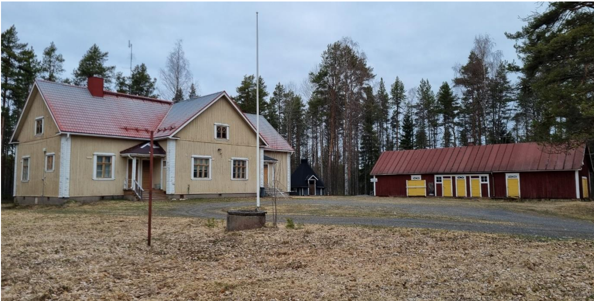
Kuva 32. Keskikylän vanha koulu, nykyinen kylätalo. Kookkaan koulurakennuksen vieressä ovat alkuperäinen ulkokuone/varastorakennus ja uudehko grillikota.
