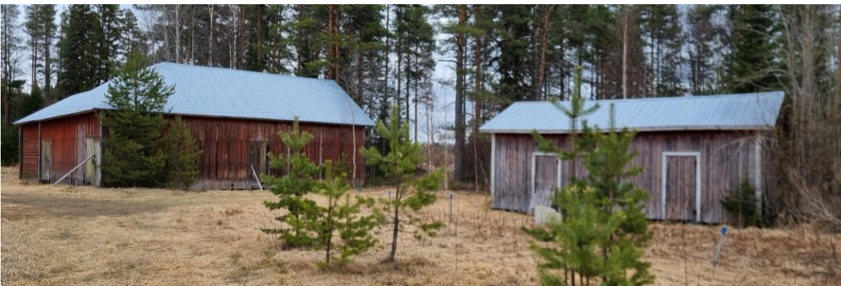
Kuva 38. Pihapiiriin pohjoislaidalla, pihaan johtavan tien molemmin puolin, sijaitsevat kookas varastorakennus / lato ja pienempi varastoaitta.
