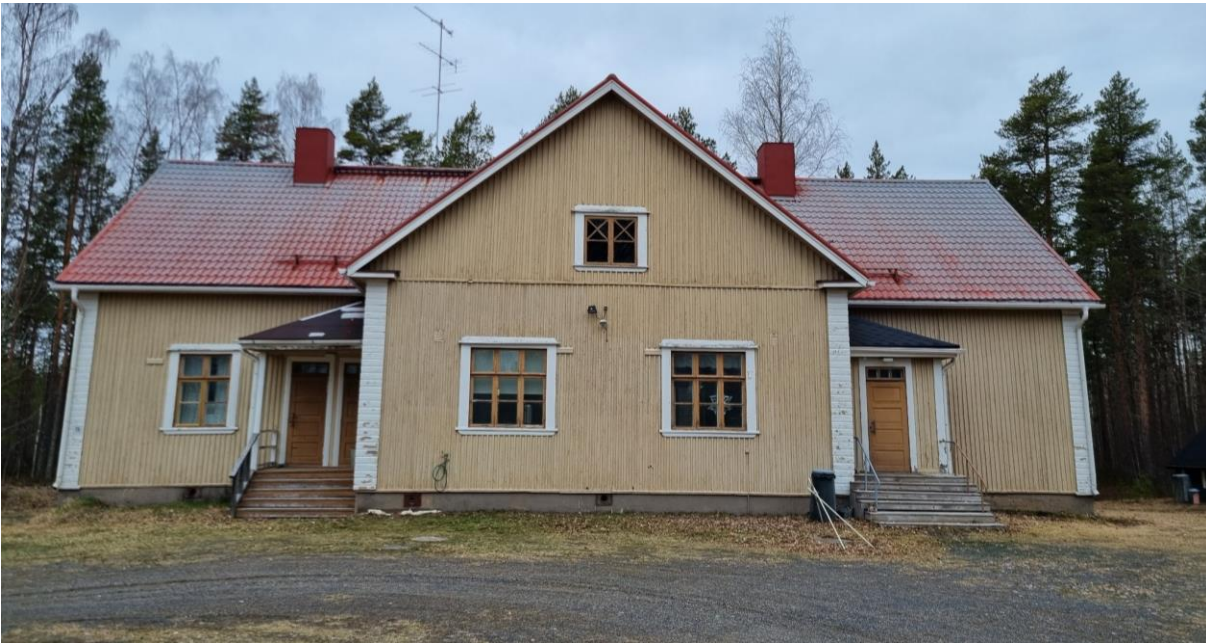
Kuva 52. Koulurakennus, julkisivu pihan puolelle.
