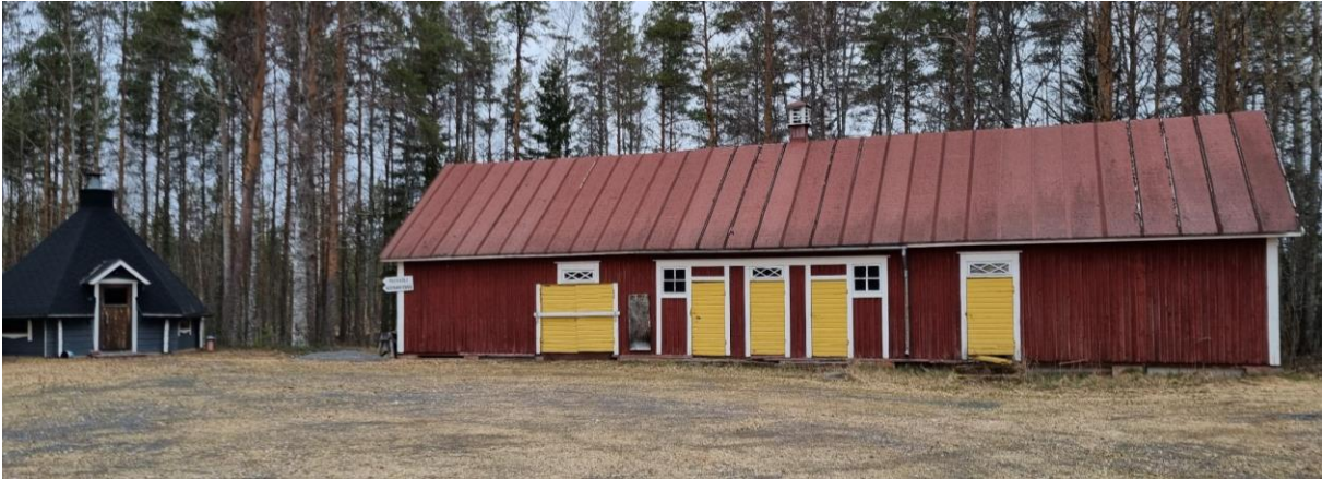
Kuva 54. Ulkokuonerakennus sijaitsee pihapiirin pohjoislaidalla.
