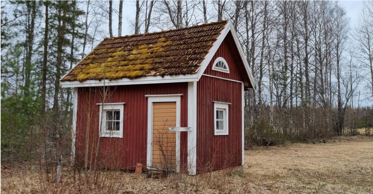
Kuva 50. Pieni saunarakennus sijaitsee pihapiirin etelälaidalla.
