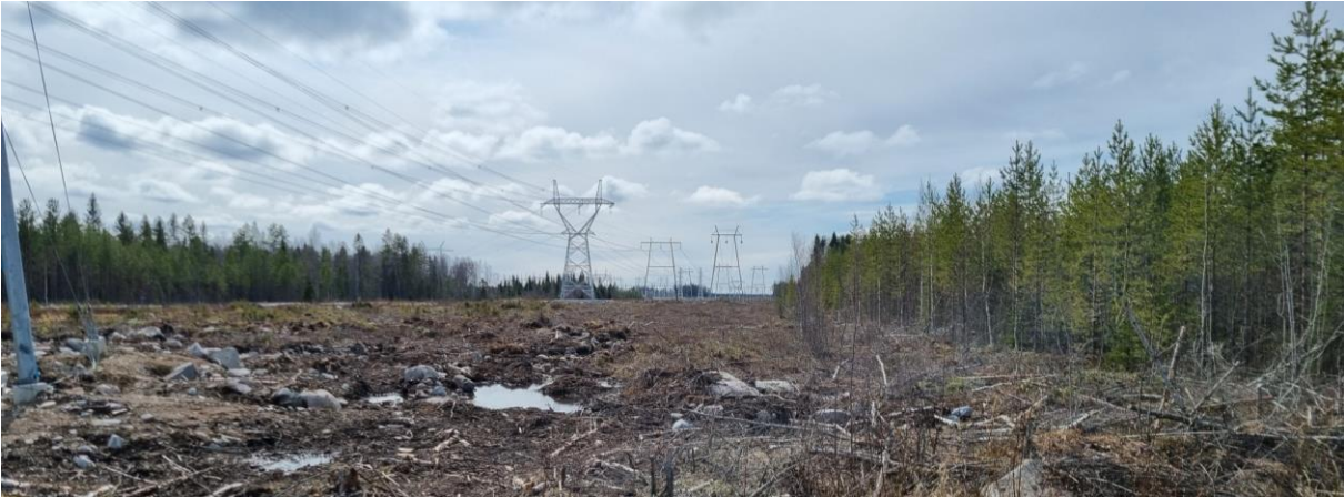
Kuva 26. Voimajohtokäytävä. Kuva sähköaseman koillispuolelta Pöytäpuunnevan tienoilta, missä rinnakkain kulkee paikallisesti kolme voimalinjaa.
