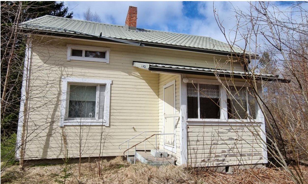
Kuva 38. Asuinrakennus on rakennettu jälleenrakennuskaudella 1950-luvun tienoilla. Rakennusta on myöhemmin uudistettu, ikkunat ja kate on uusittu.
