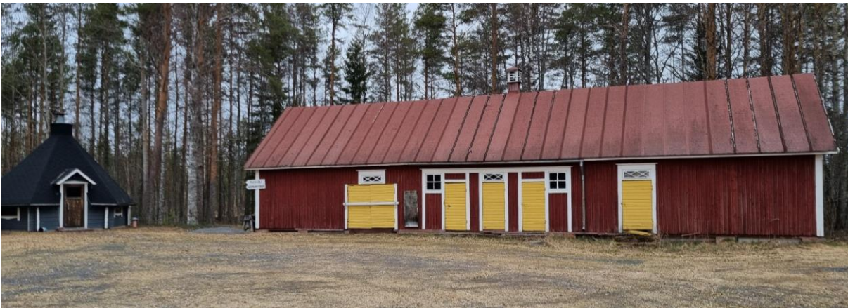
Kuva 49. Ulkokuonerakennus sijaitsee pihapiirin pohjoislaidalla.
