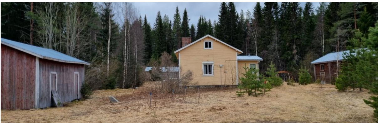
Kuva 29. Pihapiiri pohjoisen suunnasta nähtynä. Julkisivuiltaan keltaiseksi maalattu asuinrakennus sijaitsee pihapiirin keskellä. Oikealla näkyy hirsirakenteinen puoji, vasemmalla varastoaitta.
