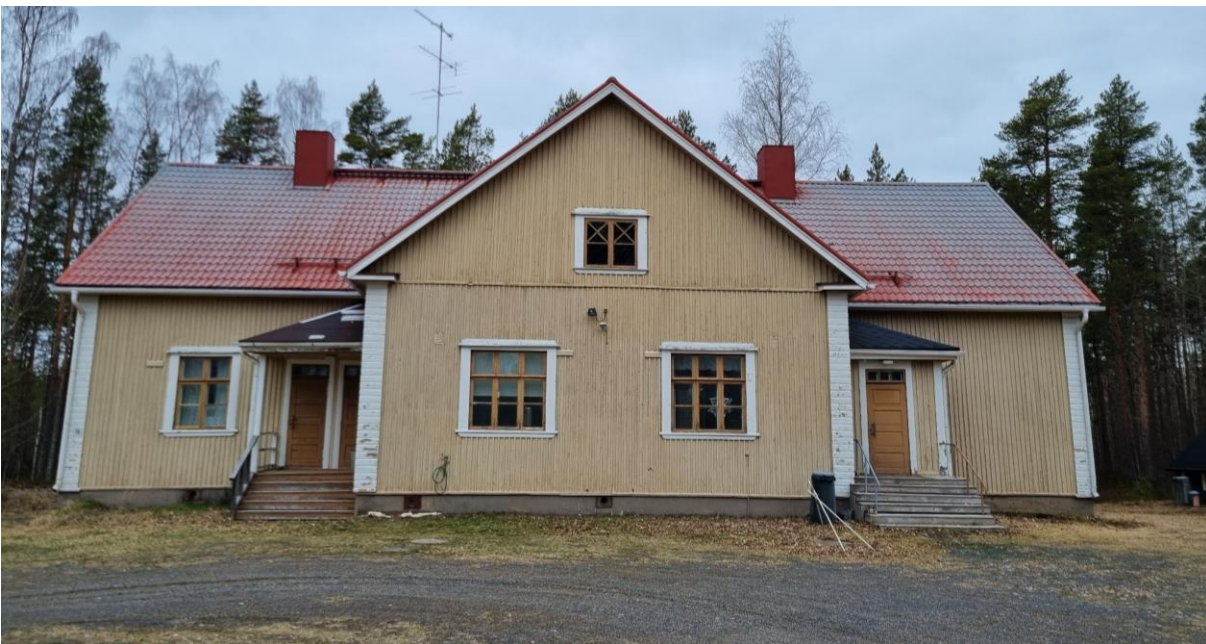
Kuva 47. Koulurakennus, julkisivu pihan puolelle.
