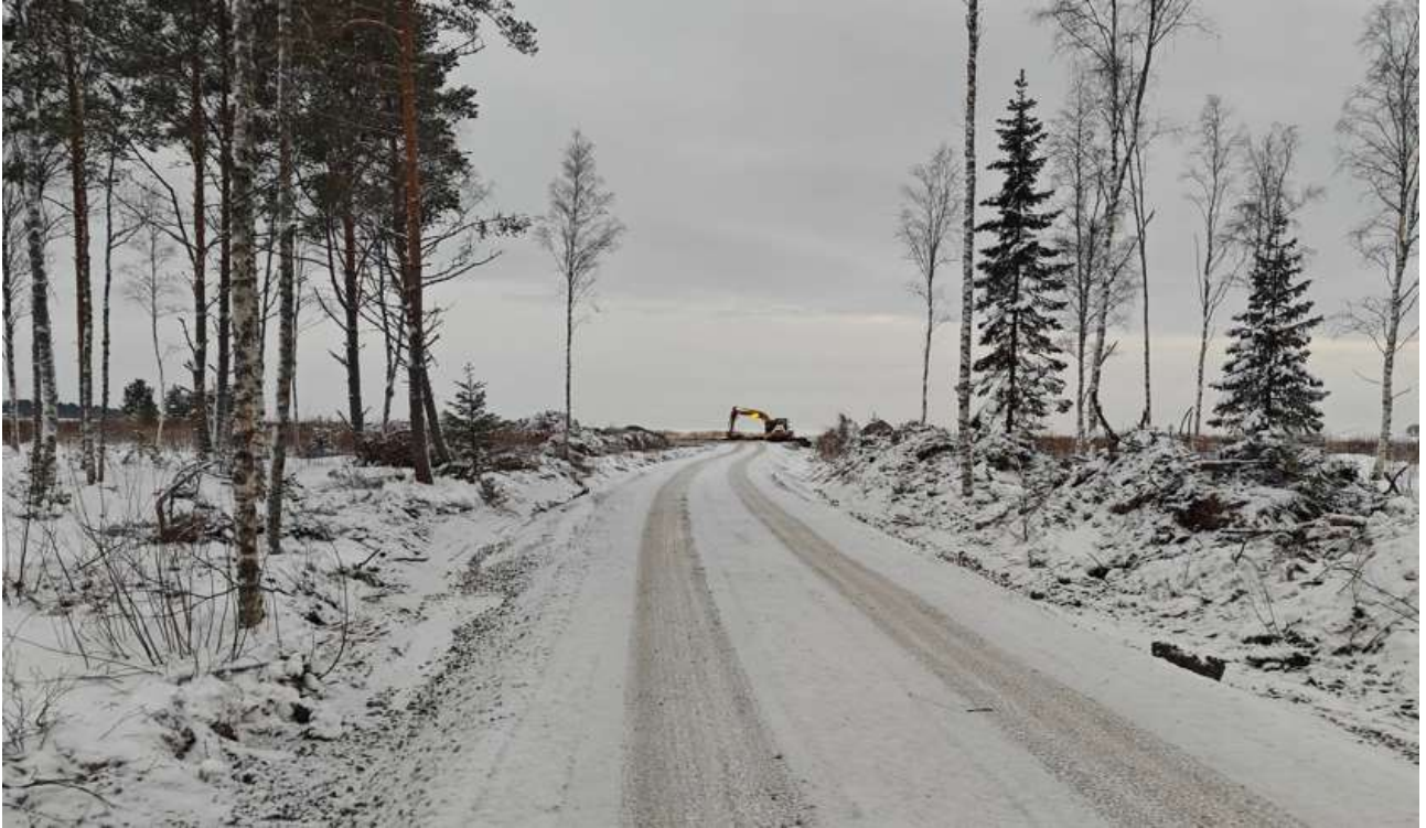
Joulukuussa 2023 tie rantaan oli jo valmis ja pysäköintialuetta vielä rakennettiin.
