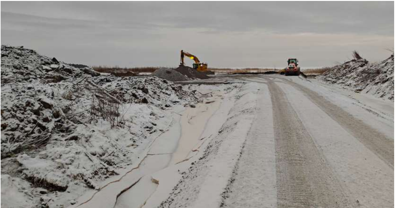
Pysäköintialue rakenteilla joulukuussa 2023.
