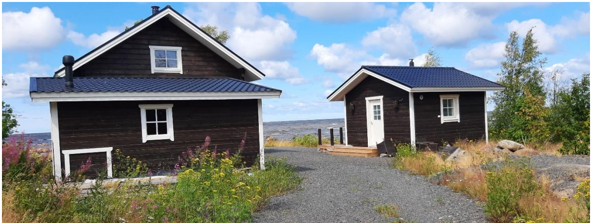
Kuva 28. Olevaa uudempaa rantarakennuskantaa Syölatissä
