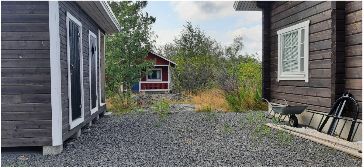
Kuva 14. Uutta ja vanhaa rakennuskantaa kaava-alueella.
